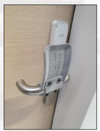
Imprimé en 3D, le support, en 2 parties vient se fixer à la porte grâce à des vis.
